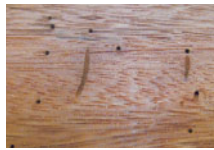
„Pinholes“ bei überseeischen Harthölzern
