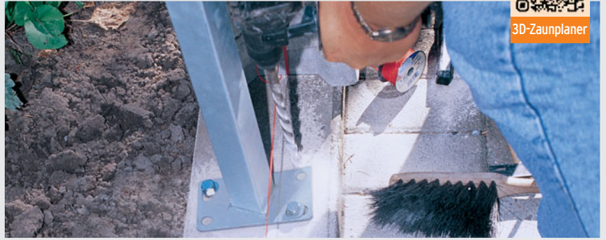
oder mit Pfostenträger aufschrauben.
