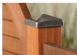
Konstruktiver Holzschutz: Schützen Sie die schichtverleimten Hartholzpfosten zwingend mit Kapfen aus Edelstahl, Seite 21.
