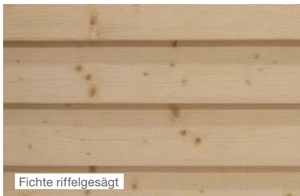
Fassadenprofil Cono (Nut/Feder und Tropfkante)
