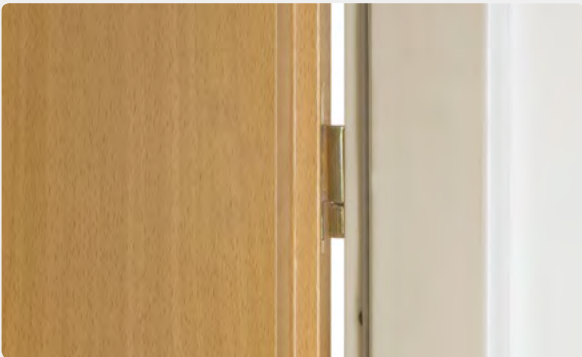
Detail TGL-Tür mit Fitschenband und Stahlzarge
